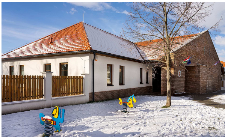
Új hatsoportos óvodaépület - 2012-2018
